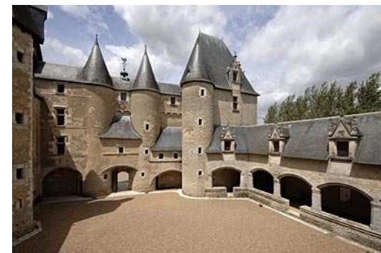
Le château de Fougères-sur-Bièvre Photo : Fougères-sur-Bièvre
