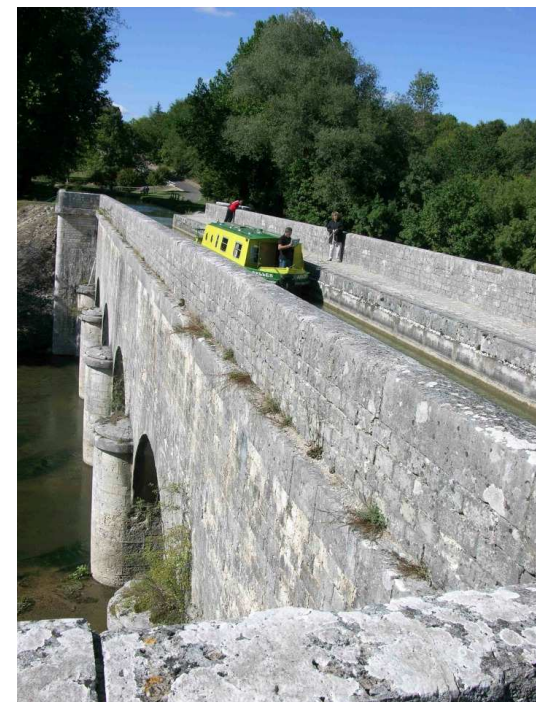
Le pont-canal de la Sauldre Photo : OT Saint-Aignan
