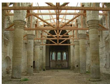
Vue intérieure Photos : Faverolles-sur-Cher
