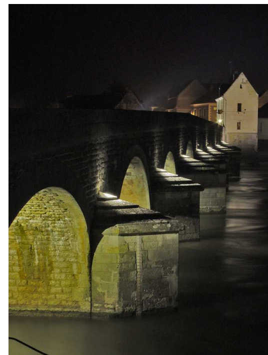
Le pont de Montrichard Photo : Néolux
