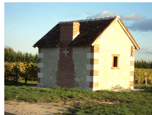
Une loge de vigne restaurée à Oisly Photo : Oisly
