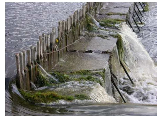
Détail des aiguilles d'un barrage Photo : Les Amis du Cher canalisé
