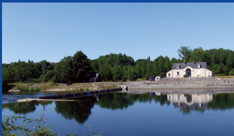
Le Cher canalisé entre Saint-Georges-sur-Cher et Chissay-en-Touraine : maison éclusière, écluse, barrage à aiguille et retenue.
