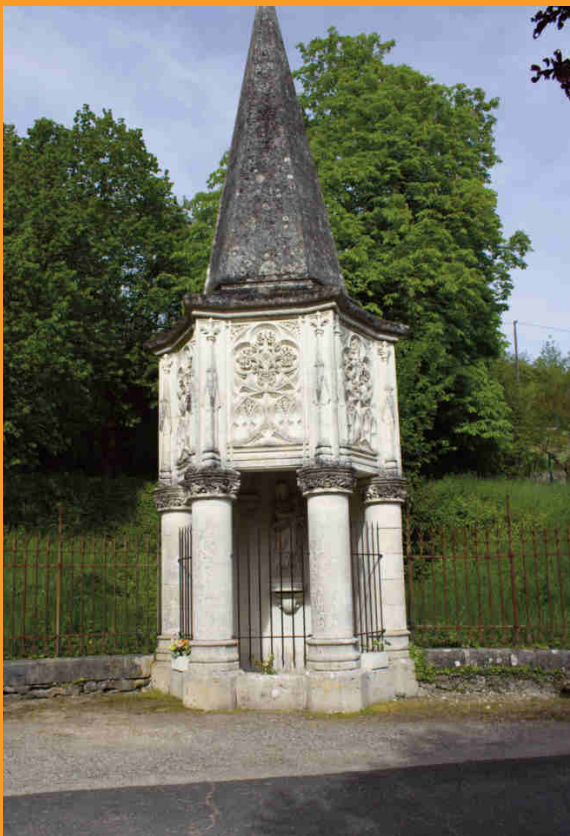
Fontaine de Nanteuil, source et bâtiment.
