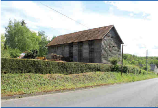
Le séchoir à tabac. Ses façades sont couvertes de volets mobiles permettant de contrôler la ventilation du bâtiment.
