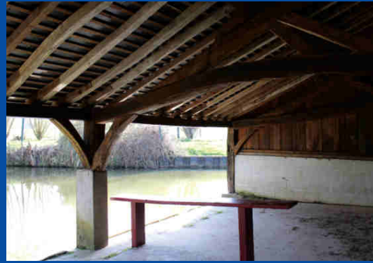
Le lavoir a été aménagé directement sur la Bièvre à quelques mètres en contrebas du moulin.
